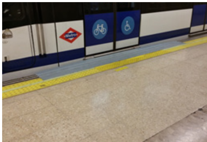
Suplemento en borde de andén instalado frente puerta de material móvil
