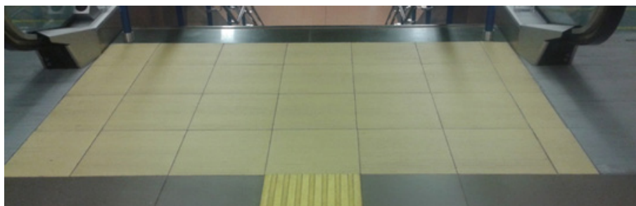
Pavimento tacto-visual cerámico en zona de embarque
