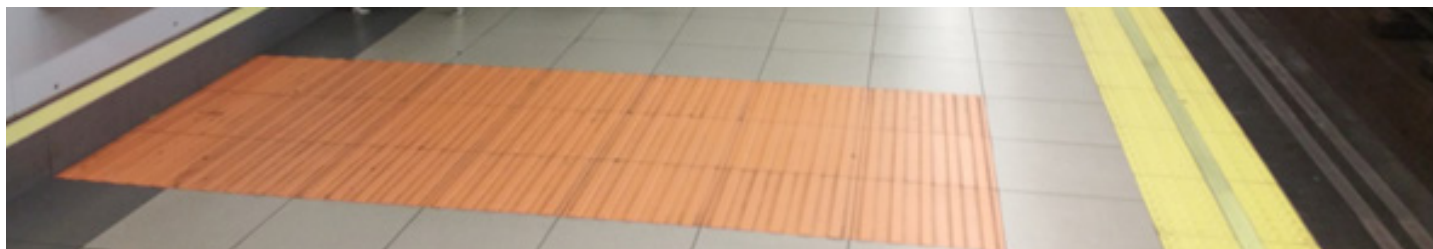
Pavimento tacto-visual cerámico en zona de seguridad en andén
